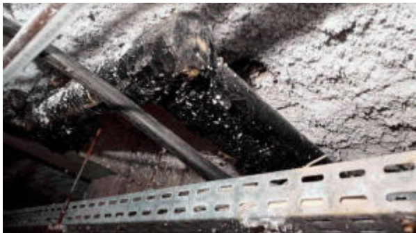
Prélèvement - P001 : R-1 / Vide sanitaire - Enveloppe de calorifuge- (Présence d'amiante)
