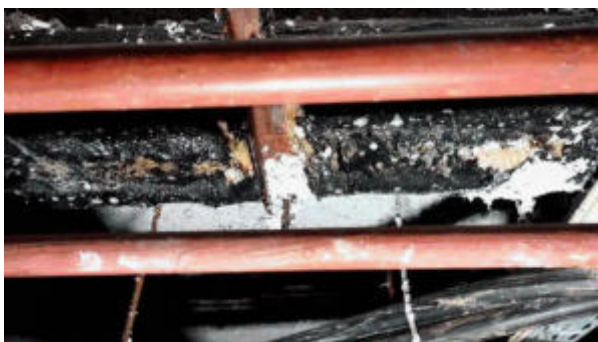
Prélèvement - P005 : R-1 / Vide sanitaire - Peinture- (Absence d'amiante)
