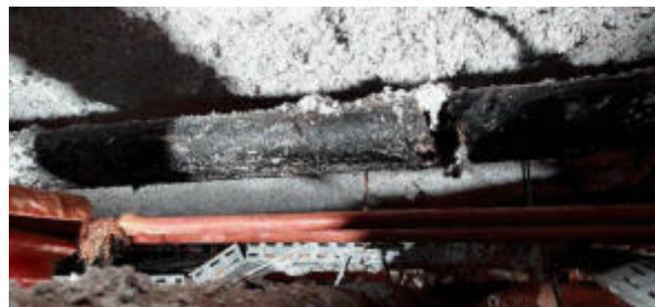
Prélèvement - P001 : R-1 / Vide sanitaire - Enveloppe de calorifuge- (Présence d'amiante)
